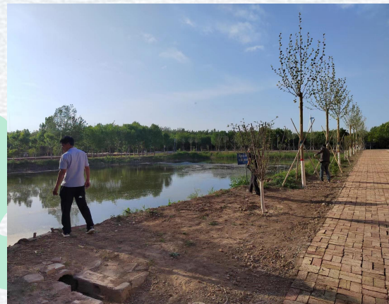
实施沟渠整治提升工程
