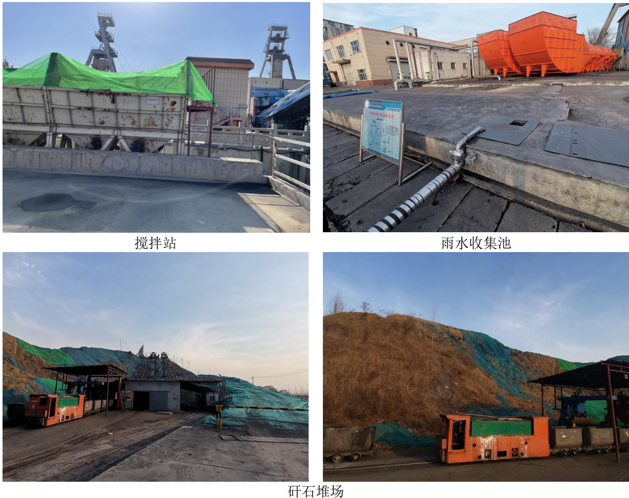
图 2.3-5 工程建设现状照片
