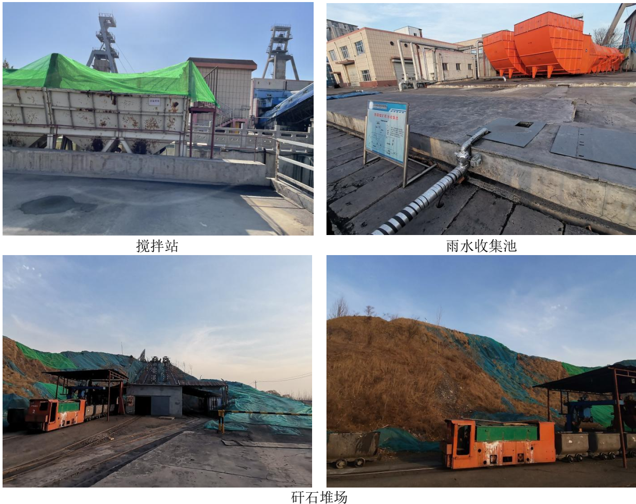
图 2.3-5 工程建设现状照片
